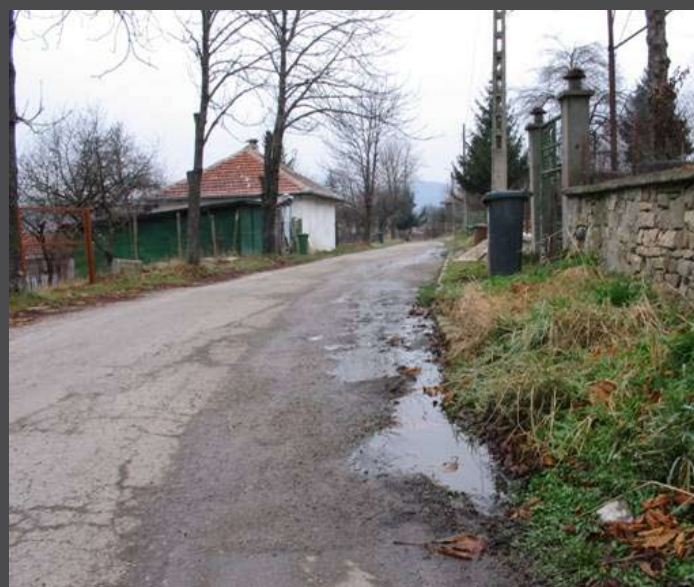
ТЕЧ ОТПАДНА ВОДА
