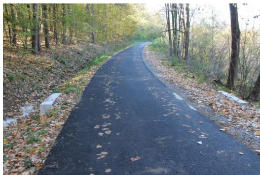
Ремонт и обезопасяване на мостово съоръжение на общински път, между селата Поповци и Гайтаните
