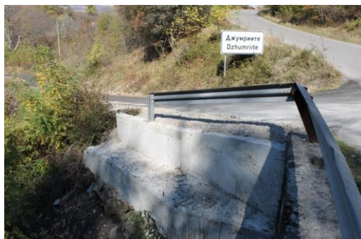
Укрепване и обезопасяване на участък от I за с. Джумриите
