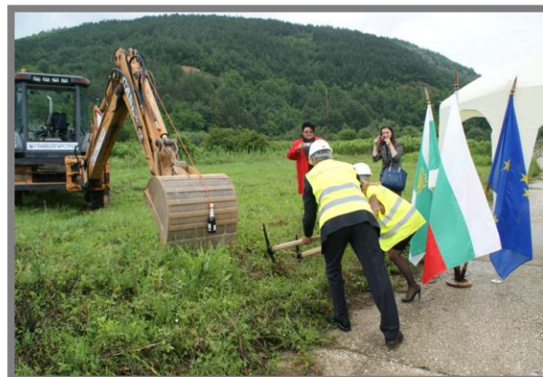
пречиствателна станция отпадъчни води
