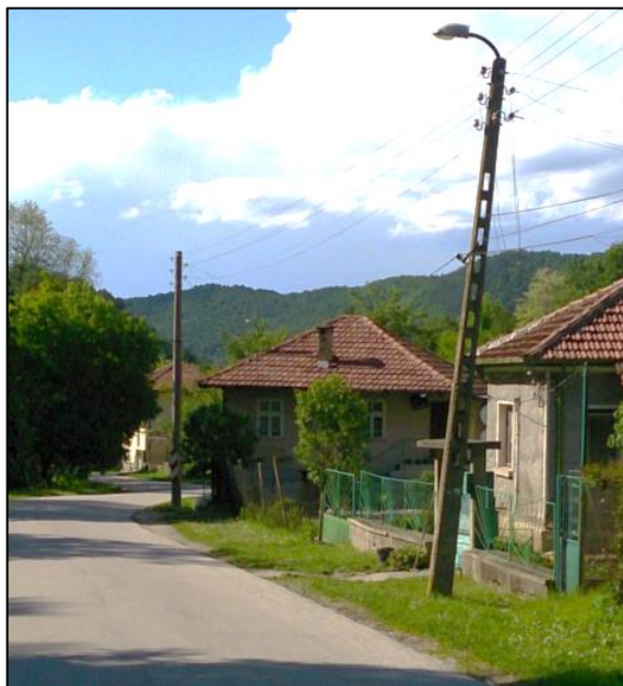
Фигура 7. Изкривен железобетонен правоъгълен стълб
